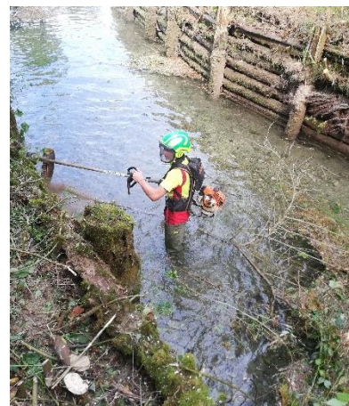
Arbeiten im Gewerbekanal
